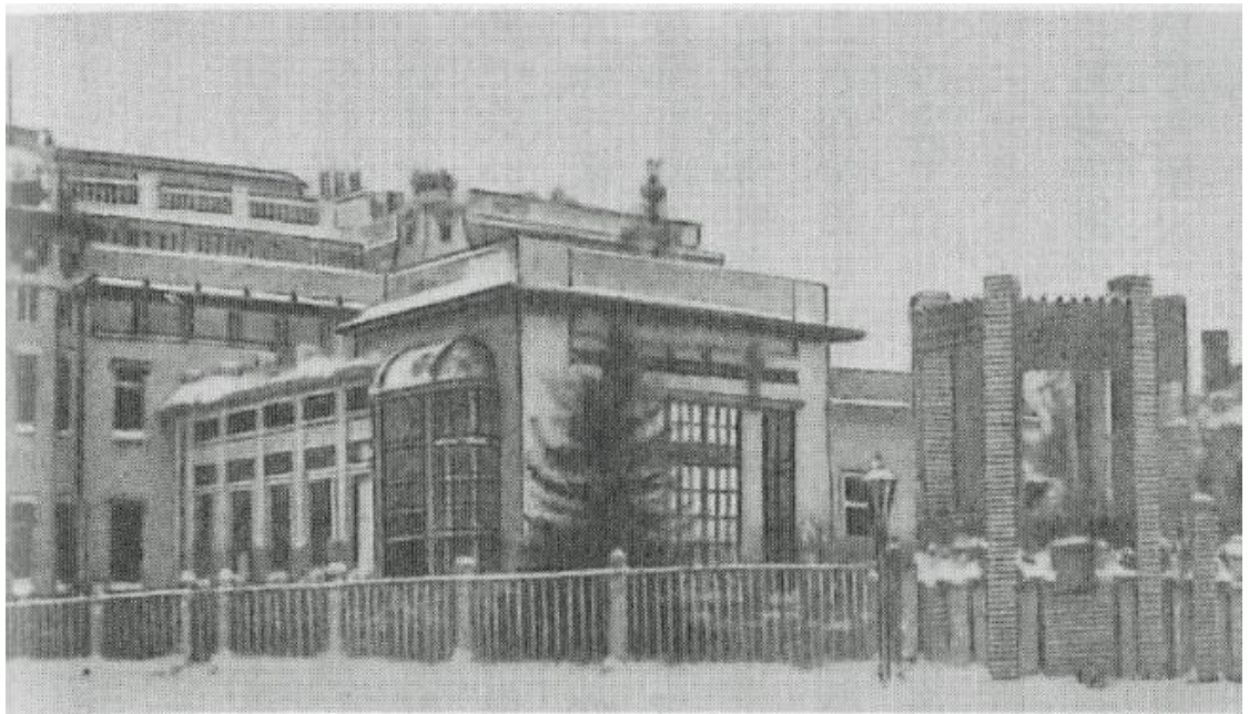
「狂人の戯言」が語られ「精霊が飛び立った」クシェーンスカヤ宮殿
